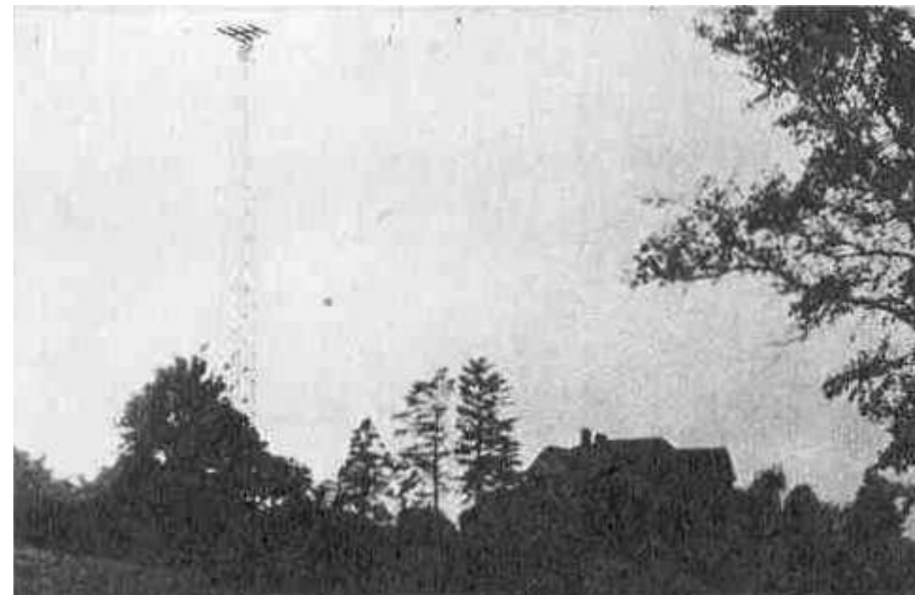
72. ábra. A kühlungsborni obszervatórium 33 MHz-es radarjának 50 m magas tornya a függőleges tengely körül (percenként kétszer) forgó adó-vevő antennájával
